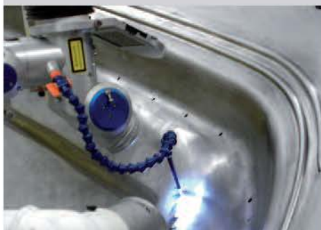
Soudage de réparation (photo : PML Lasertechnik, Nohra)
